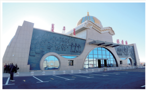
镶黄旗通用机场。
