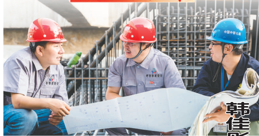
韩佳彤(中)在施工现场为团队人员指导工作。
