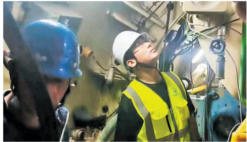
石韬在顶管施工技术中进行指导。
