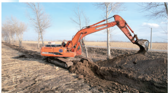
绰勒水利枢纽下游内蒙古灌区田间工程施工现场。
