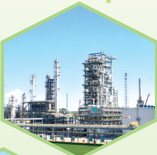
内蒙古伊泰煤油有限责任公司16万吨/年煤制油工业化示范项目。
