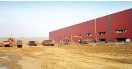
明阳智慧能源集团股份公司5-10MW新能源超大型陆上风机整机及关键核心部件智能制造项目建设中。
