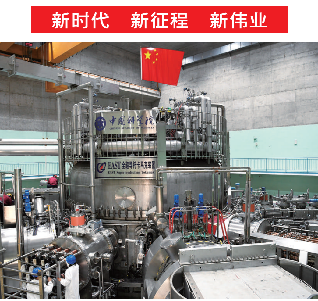
在中科院合肥物质科学研究院,工作人员对有人造太阳之称的全超导托卡马克核聚变实验装置(EAST)进行升级改造(2021年4月13日报)。
