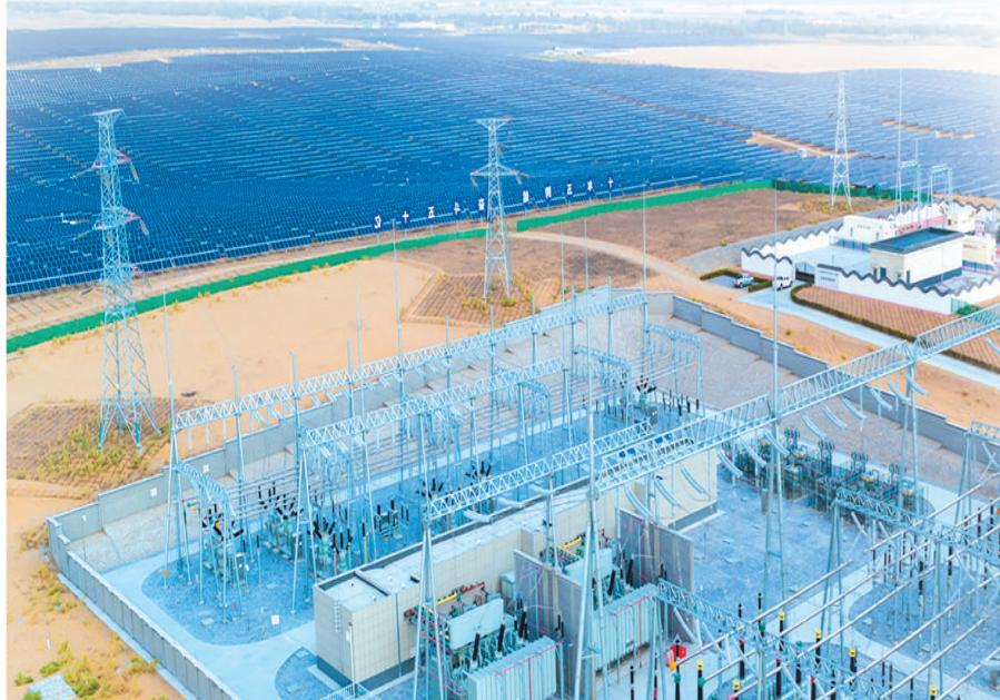
在库布其沙漠腹地，一座座巨大的风车挥动着白色的风机叶片，湛蓝的光伏板汇聚了太阳的光芒，通过6条220千伏输电线路，汇入内蒙古首座外送特高压新能源汇集站——伊和乌素500千伏鸿沁湖变电站，将80万千瓦瓦绿色的清洁能源并入电网输送至齐鲁大地，隆起了内蒙古电网外送“电力动脉”的新高度。
