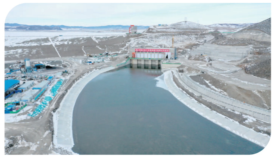
文得根水利枢纽发电厂及鱼道。
