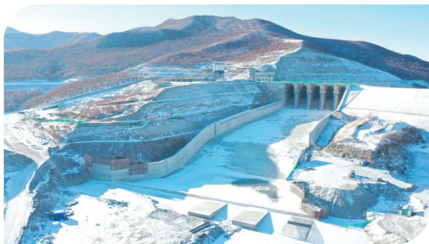
大坝溢洪道落成。
