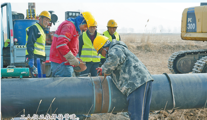
工人正在焊接管道。
