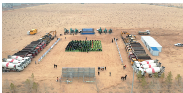
二连浩特市第四小学迁址新建项目现场。
