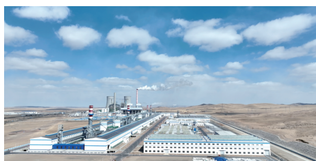
西乌珠穆沁旗白音华煤电有限责任公司年产40万吨高精铝板带项目现场。
