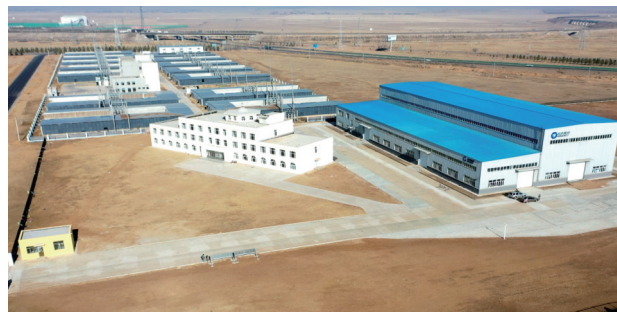
正蓝旗运达中再风光设备循环利用基地。
