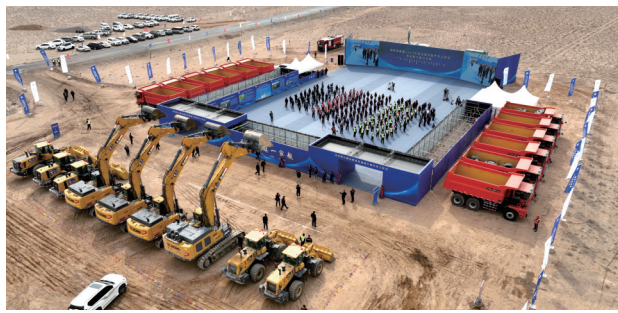
苏尼特左旗中煤芒来2×66万千瓦煤电一体化项目。
