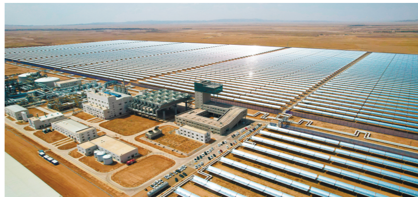
乌拉特中旗100兆瓦槽式光热电站。
