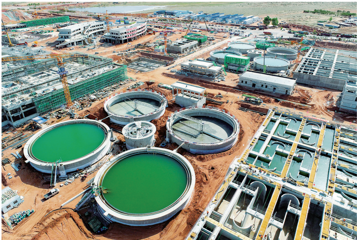
鄂尔多斯:零排放水资源再生利用项目建设进入冲刺阶段
