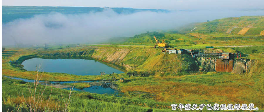
百年矿坑已实现披绿换装。
