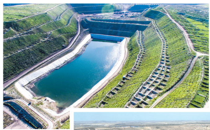
中水调蓄利用工程有效保障绿色矿山建设。
