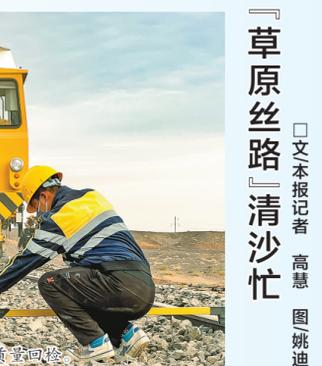
80%的路轨处于沙漠、戈壁,铁路道床常年会有风积沙堆积,给列车安全运输带来隐患。在临哈铁路沙化严重的52公里道床上,呼和工务机械段集中组织机械和专业人员,像过筛子一样对风积沙、沙尘、污土进行清理,同时补充大量碎石,以恢复铁路道床弹性和渗水功能,确保货运班列安全运行,助力经济大循环。
