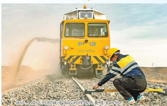
近日,在临哈铁路苏宏图至阿达日嘎段,中国铁路呼和浩特局呼和工务机械段组织16台专门服务于铁路养护的大型机械开展清沙作业。
