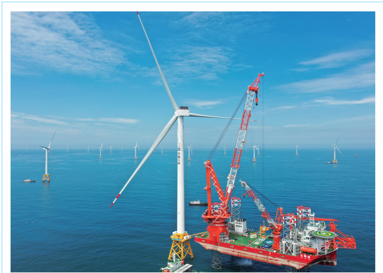
全球首台16兆瓦海上风电机组在福建成功吊装
