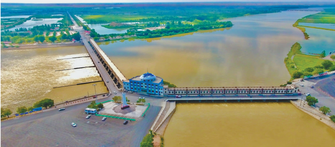
航拍黄河三盛公水利枢纽。黄河三盛公水利枢纽地处巴彦淖尔市磴口县与鄂尔多斯市杭锦旗接壤处的黄河干流上,是一座以灌溉为主,兼有防洪、发电、供水、交通的大型闸坝工程,有“万里黄河第一闸”之称。 本报记者 孟和朝鲁 摄
