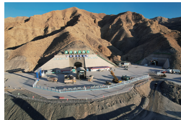
正在建设的乌海抽水蓄能电站项目。黄建飞 摄
