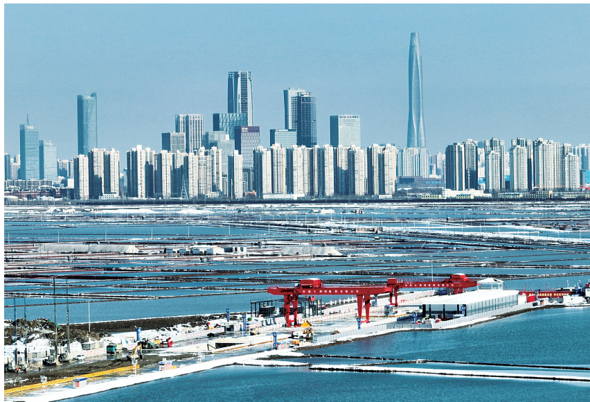
2024年1月18日拍摄的盾构机始发站(无人照照片)。当日,由中铁十四局承建的津雄高铁津涿河隧道超大直径盾构机“津城一号”顺利始发,标志着京津冀地区开挖直径最大、掘进距离最长的高铁盾构隧道正式开始掘进。
