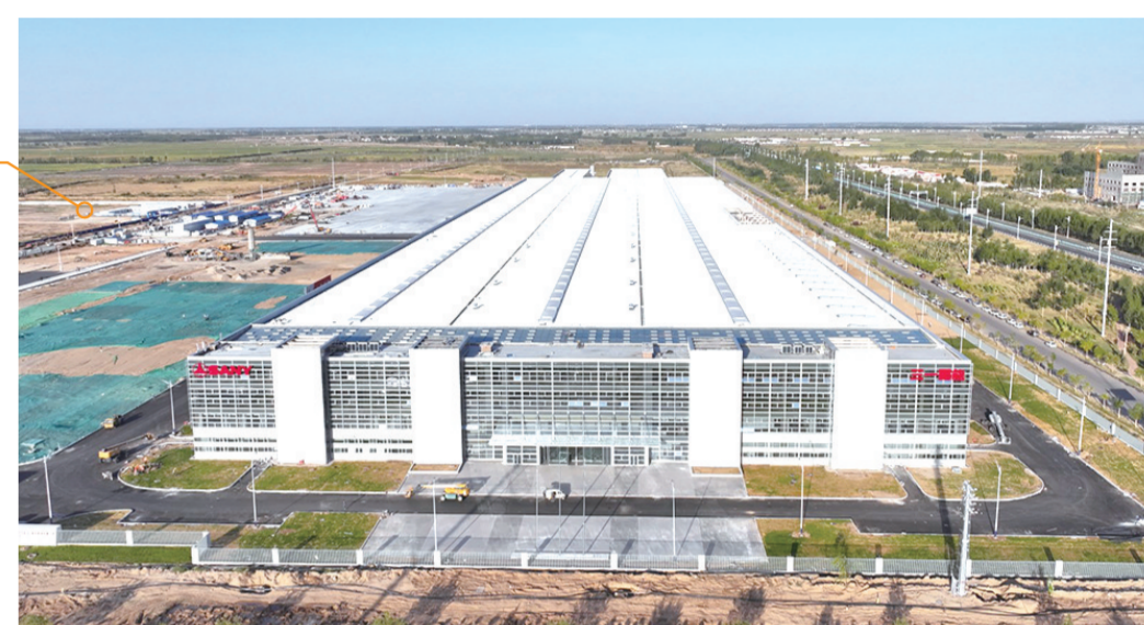
巴彦淖尔——三一零碳产业园一期建设项目。
