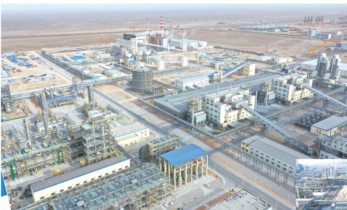
乌海——内蒙古三维新材料有限公司BDO一体化项目。
