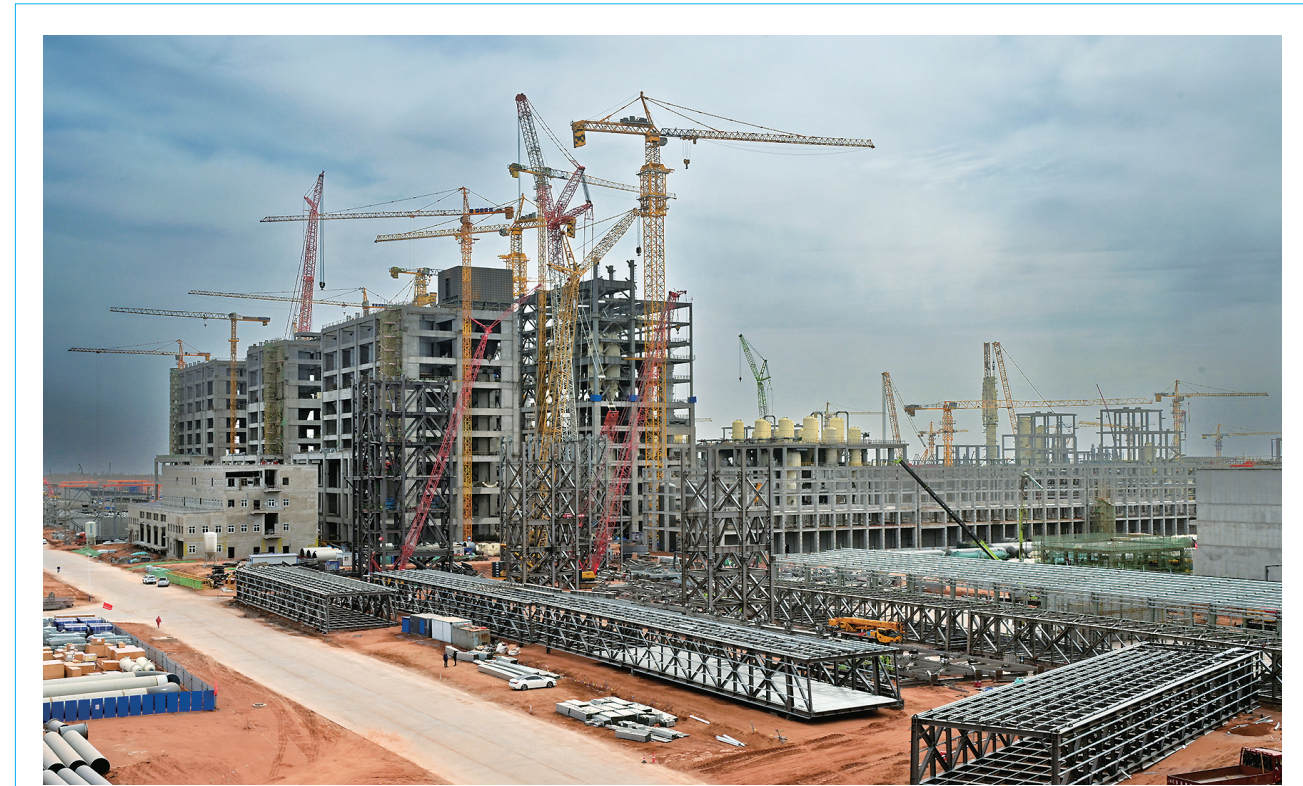
全球最大煤制烯烃项目加紧建设
