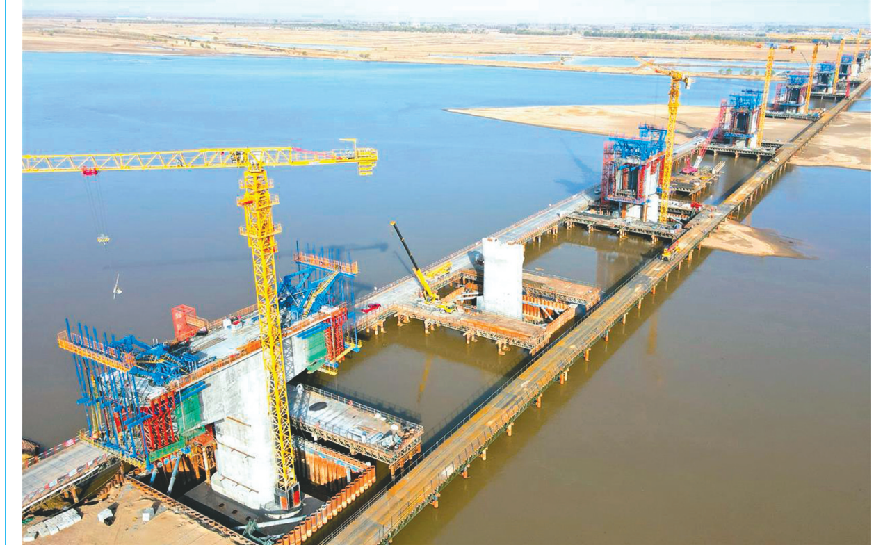
重点工程建设正酣
