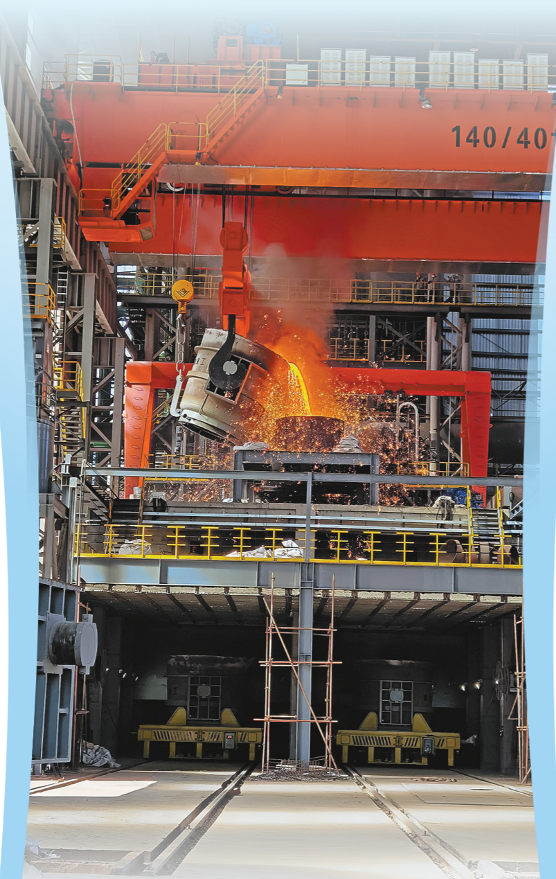
内蒙古赛思普科技有限公司建设的氢基熔融还原冶炼高纯铸造生铁生产线。
