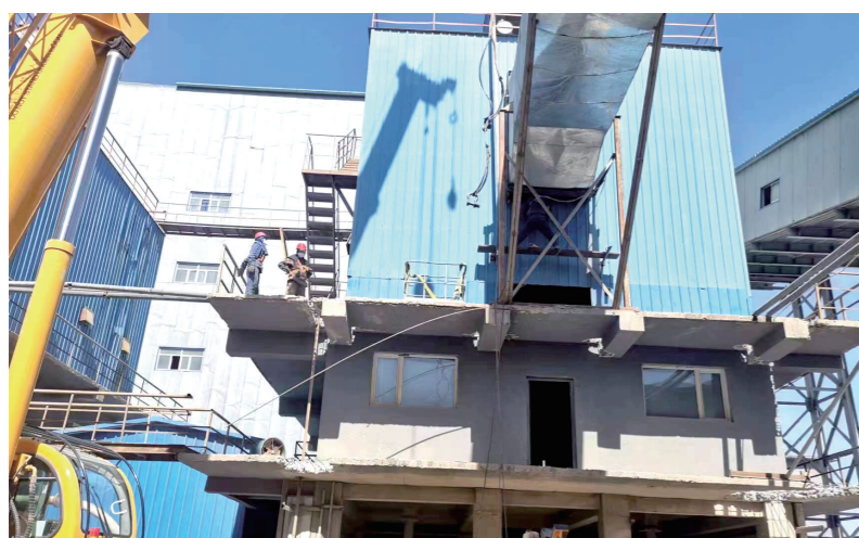
超低排放改造施工。
