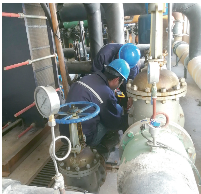
换热站升级改造工作。
