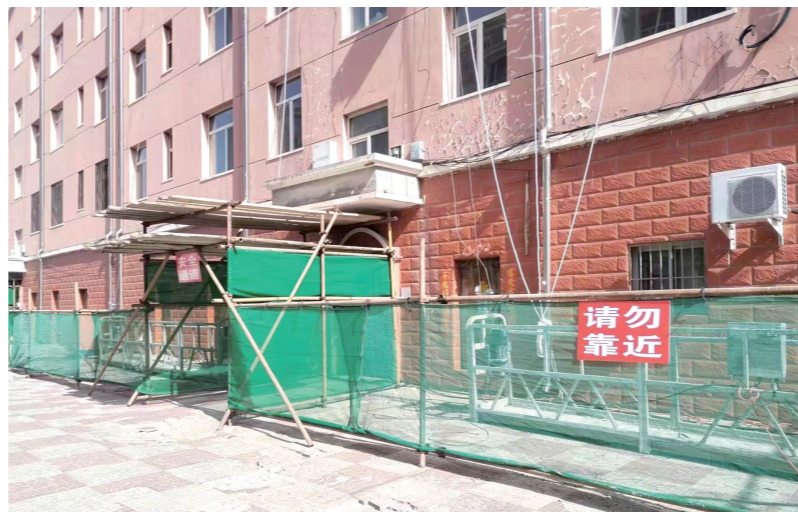
契丹商贸小区节能改造施工。
