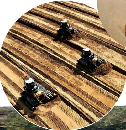
连日来,阿拉善盟李井滩生态移民示范区扎实推进阿拉善盟内西部荒漠化综合治理项目(二期)实施,在塔木素布拉克施工区的施工现场,800余名工人正在按计划分工作业,划线开沟、削身铺草、碾压整理、填沙整型,治沙队所过之处,留下了整齐划一的网格沙障,给茫茫沙漠披上了牢固的“格子衫”。
