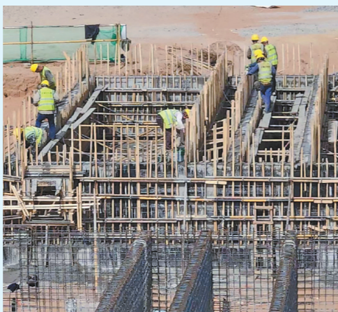
内蒙古能源集团杭锦旗风光火储热生态治理项目升压站建设现场一片繁忙。
