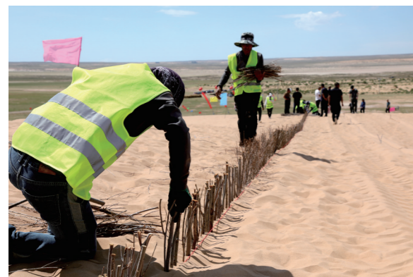
裸露的沙地里扎起沙障。
