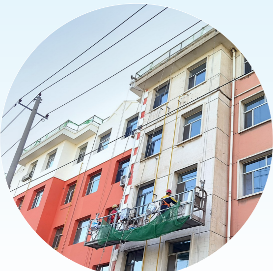
为老旧小区楼体加装外墙保温。赵荣 摄
