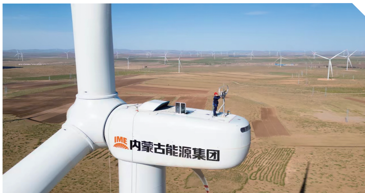
内蒙古能源化德县100万千瓦风光储项目。
