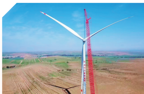
内蒙古能源四子王旗100万千瓦风储项目。
