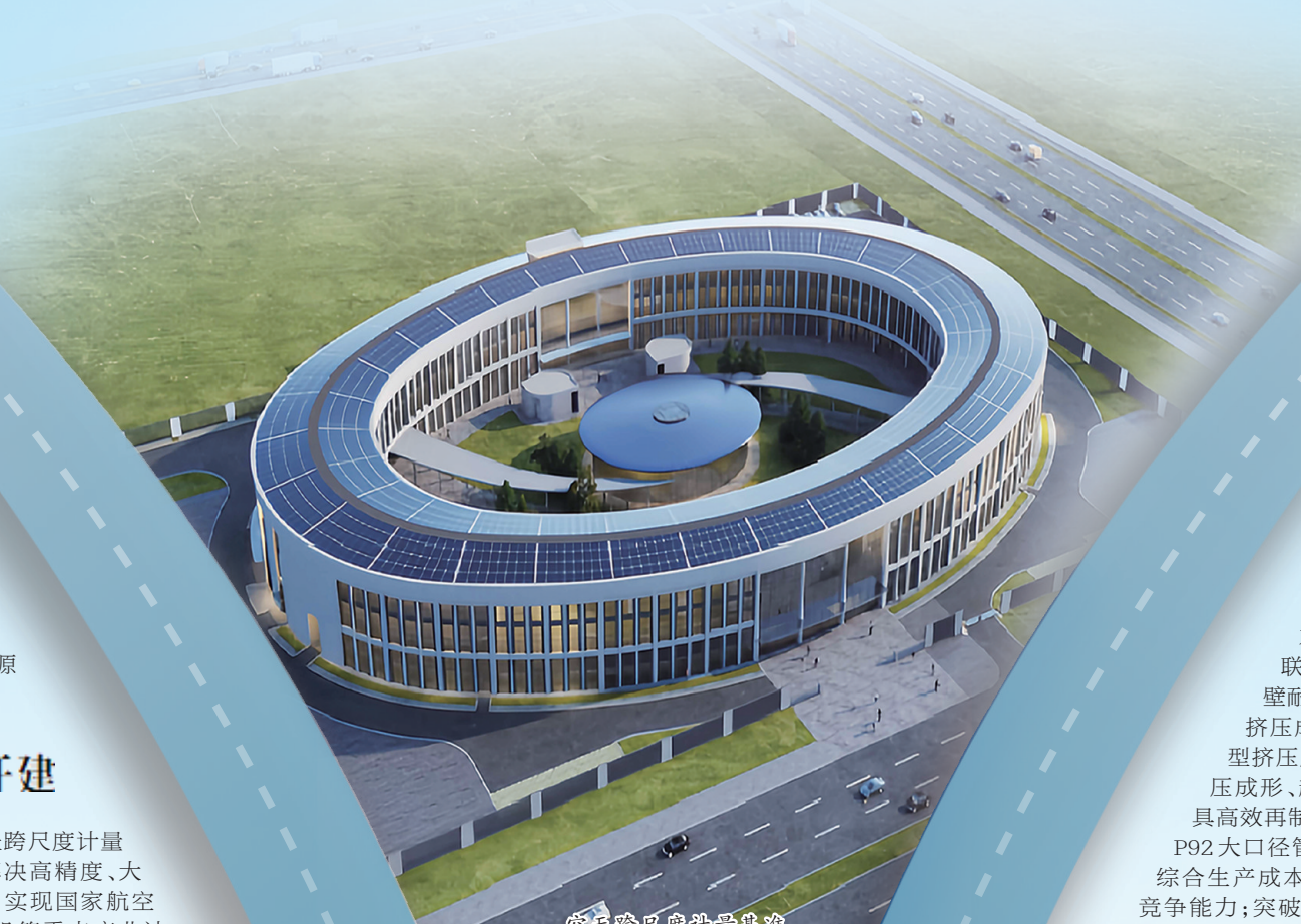
空天跨尺度计量基准大科学装置建设现场。
