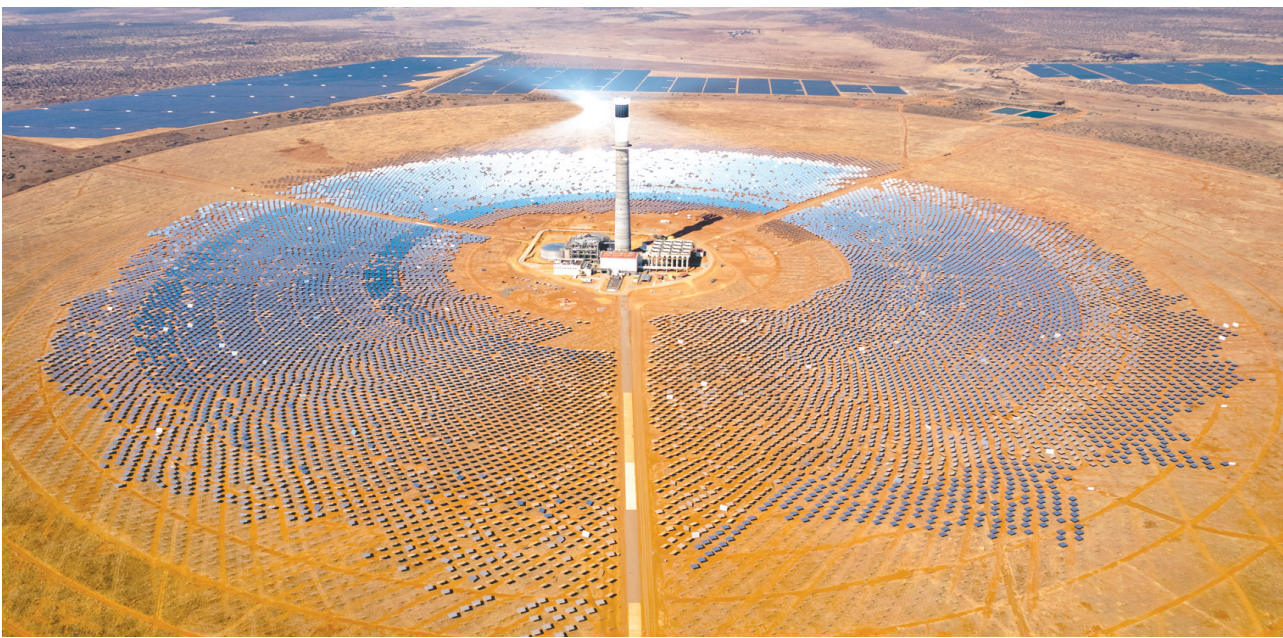
这是2024年8月20日在南非北开普省拍摄的由中国电建集团山东电建三公司承建的南非红石100兆瓦塔式熔盐光热电站项目(无人机照片)。该项目是撒哈拉以南非洲首个塔式熔盐光热电站项目，也是南非最大可再生能源投资项目之一。
