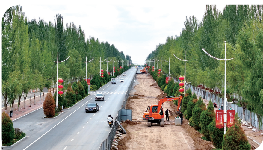
“温暖工程”杭锦旗施工现场。
