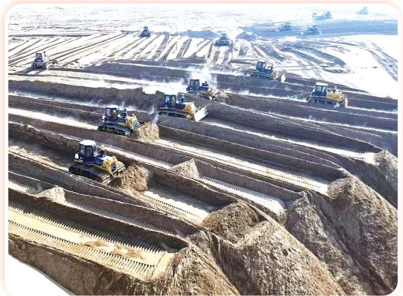
库布其沙漠光伏长城开工现场。
