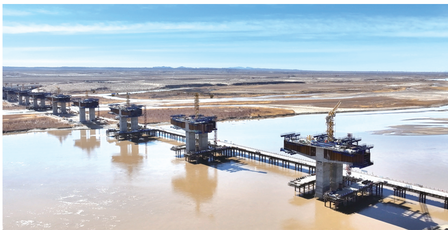
110国道磴口黄河大桥提速攻坚
