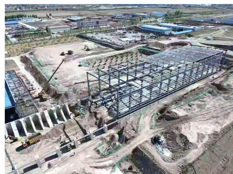
今年开工建设的新项目 新疆特变铁塔筒项目。
