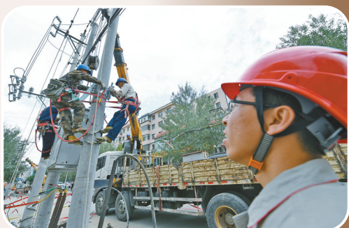
更换10千伏杆上变压器。
