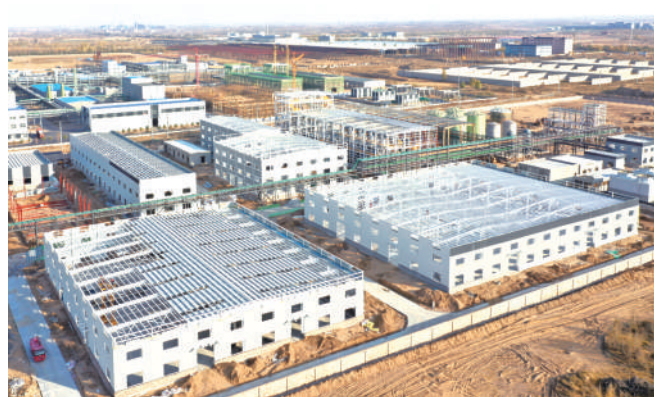
蒙泰东胜二期2×66万千瓦热电联产项目建设现场。
