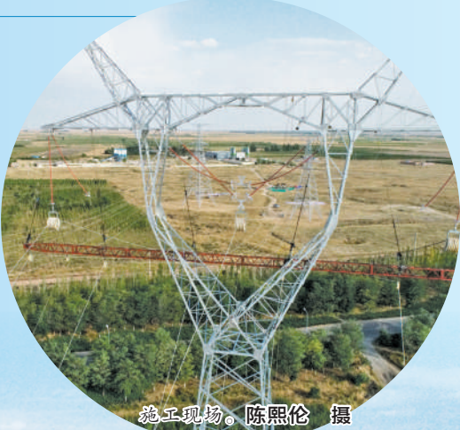
施工现场。陈照伦 摄
