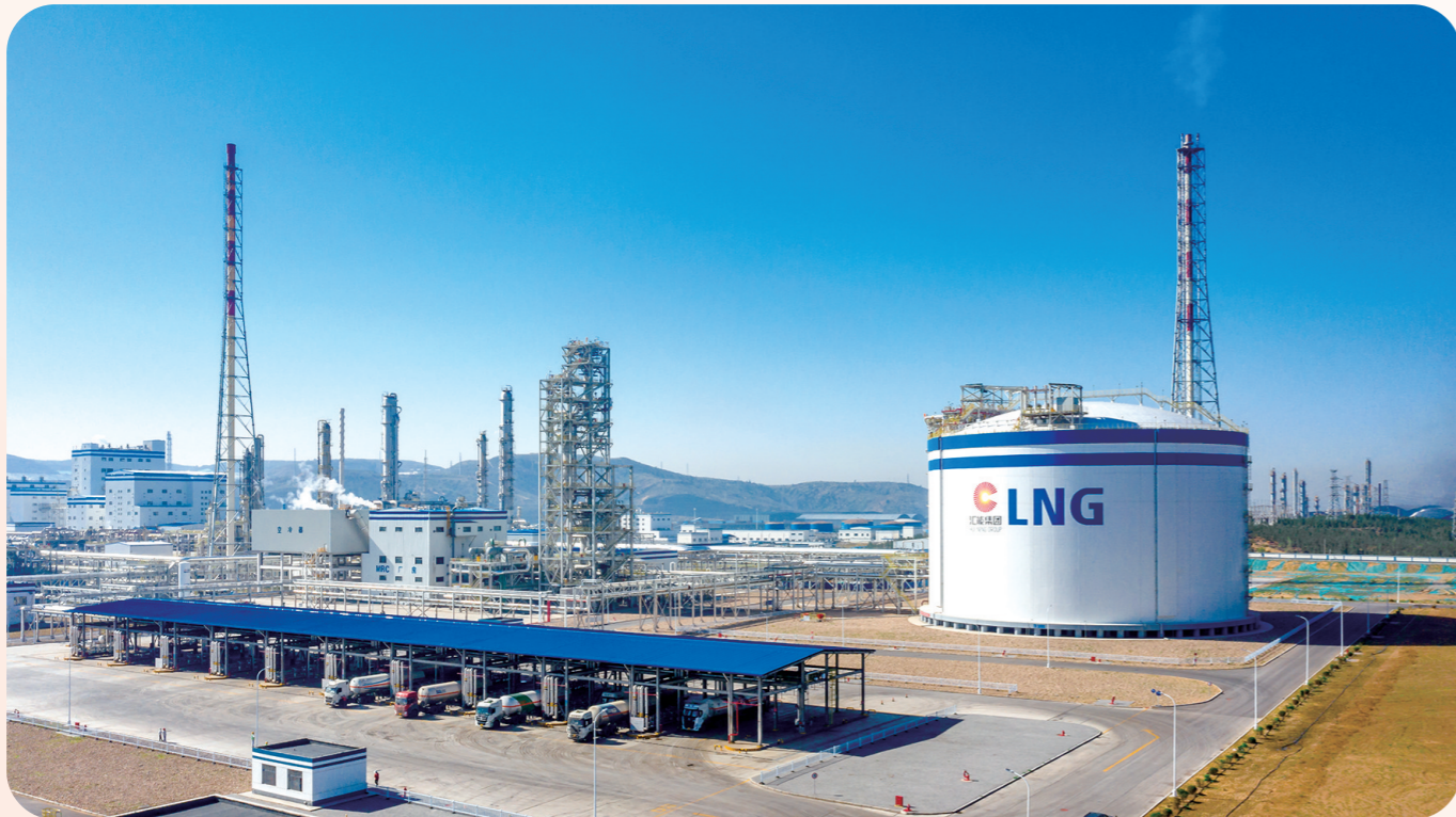
内蒙古汇能煤化工有限公司二期液化储罐及加液站。
