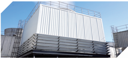
内蒙古瑞达泰丰化工有限责任公司新投用的循环水冷却塔,减少循环水蒸发量,每年节约用水约1万吨。
