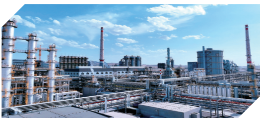
阿拉善盟沪蒙能源集团有限公司的干熄焦技术不仅年节水100万吨,还能发电4.8亿度,实现“一水双效”。
