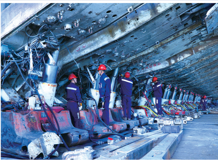
设备维修中心员工加强预防性检修。
