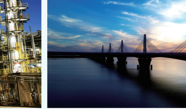
乌海湖大桥在暖色调的映照中。
