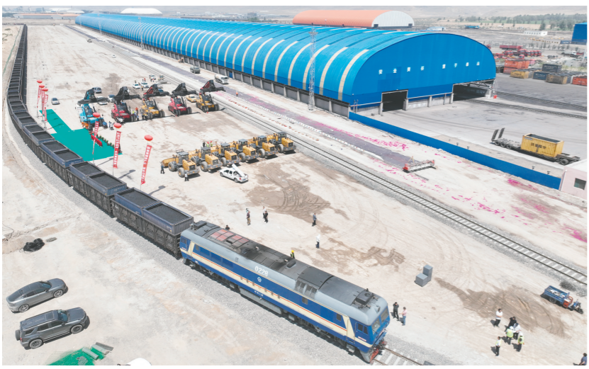
金泉南煤炭铁路专用线首发
