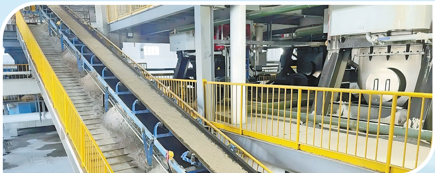
中建材通辽矽砂工业有限公司甘旗卡砂矿年产30万吨光伏砂及20万吨低铁长石试生产车间。
